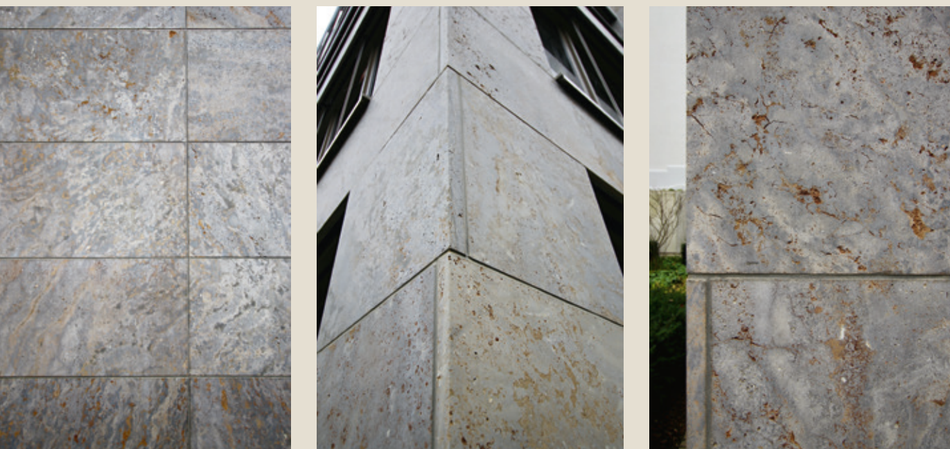
Beeindruckende Bandbreite an Farbschattierungen und Oberflächenstrukturen: Um einen sogenannten Tapetencharakter zu vermeiden, wurde die Fassadenecke verzahnt gearbeitet
