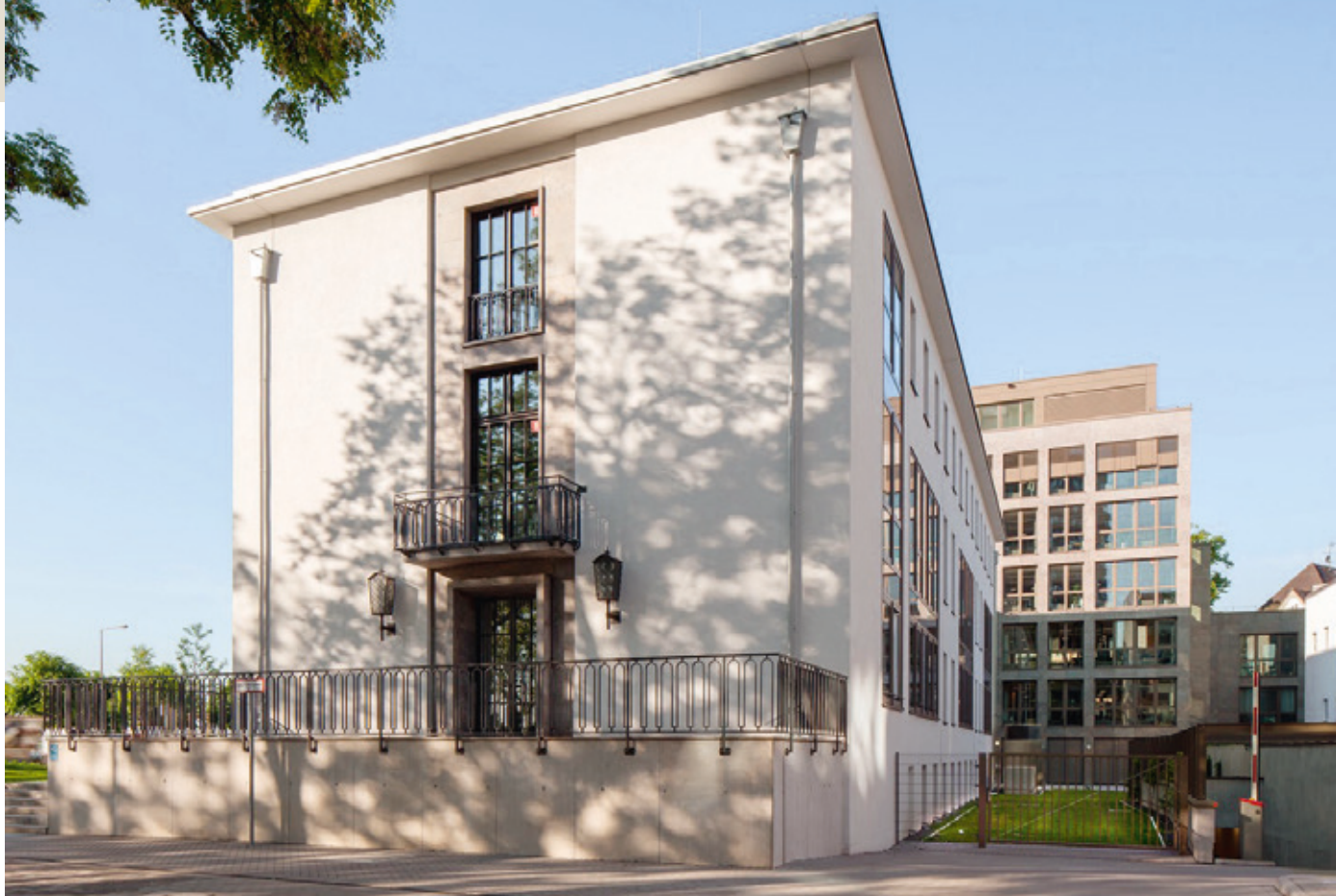
Rahmen aus Muschelkalkplatten: Die Fenster und Türen des historischen Gebäudes sind mit Naturstein verziert. Im Hintergrund ragt die moderne, etwas dunklere Fassade aus Mooser Muschelkalk hervor
