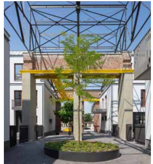
Die historische Kranbahn fand - zinkgelb gestrichen - einen neuen Platz.
