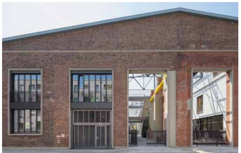
Blick von Norden auf die monumentale Halle mit 12 m Höhe
